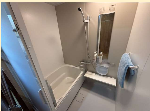
町補助事業にて整備した浴室
